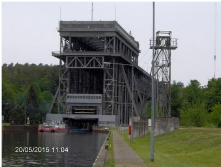
Schiffshebewerk Niederfinow Gesamthöhe des Bauwerks 60 m
